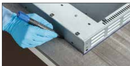
Marquez le périmètre du système sur le dos de la dalle.
