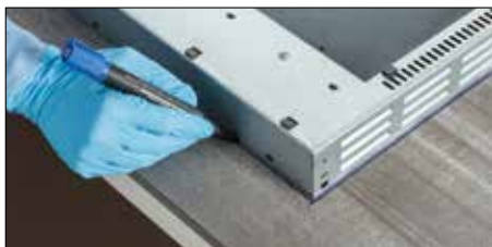
Marque el perímetro del sistema en el reverso de la losa.
