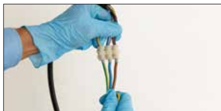
Collegare i cavi elettrici e accendere l'interruttore principale. Terminare il montaggio del mobile.
