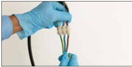
Conecte los cables eléctricos y encienda el interruptor principal. Termina de montar los muebles.
