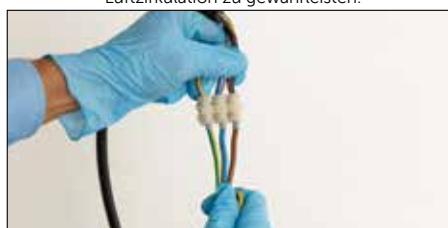
Schließen Sie die elektrischen Kabel an und schalten Sie den Hauptschalter ein. Beenden Sie den Zusammenbau der Möbel.
